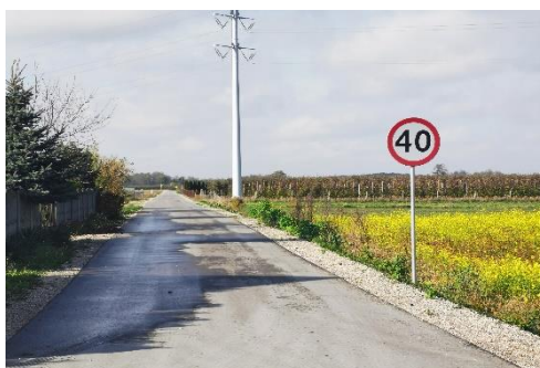
Przebudowa drogi w Rylsku Małym
