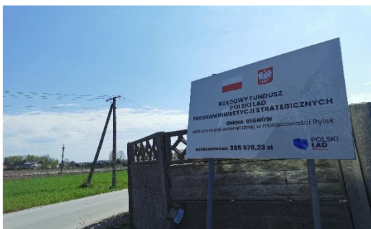
Remont drogi wewnętrznej w Rylsku
