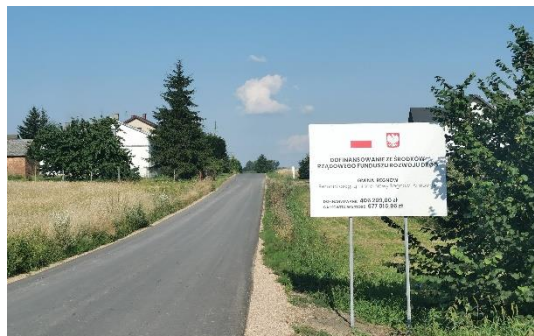
Remont drogi gminnej Nowy Regnów-Annosław
