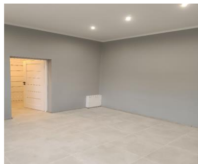
Fot. Pomieszczenie socjalne w budynku OSP w Regnowie po przeprowadzonym remoncie w 2023 r.
